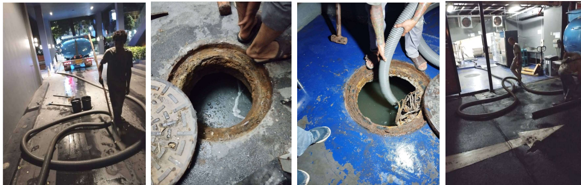
ภาพที่ 4-7 การสูบน้ำและบ่อกักตะกอนออกทุก 3 เดือน
