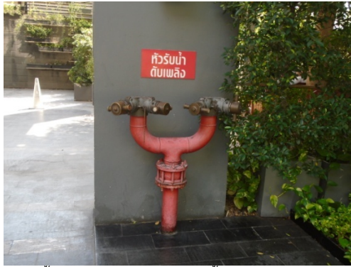
ภาพที่ 4-26 หัวรับน้ำดับเพลิงจากภายนอกติดตั้งไว้ใกล้กับทางเข้า-ออกโครงการ
